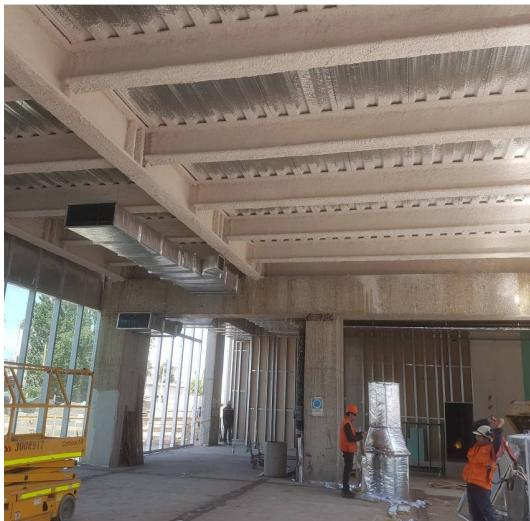
El mortero IGNIVER se aplica por vía húmeda mediante máquina de proyección. Consultar la tabla de masividades para determinar el espesor de aplicación en cada caso [www.volcan.cl/igniver](http://www.volcan.cl/igniver).
