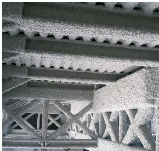
El Mortero para protección de túneles, compuesto de roca, cemento y material refractario en pequeñas lana proporciones, ha sido diseñado específicamente para la protección contra el fuego en industrias.
